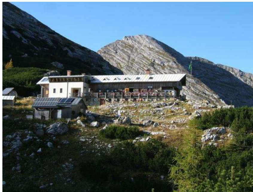
Hesshütte mit Photovoltaikanlage
